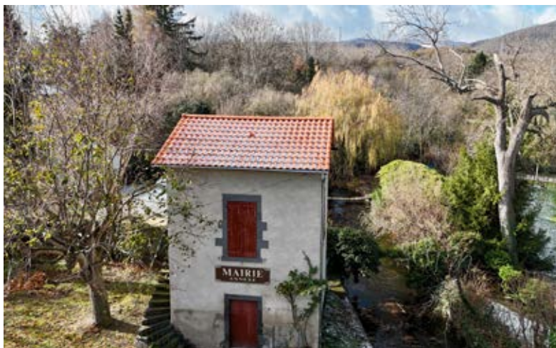
Restauration de la toiture de la mairie annexe
